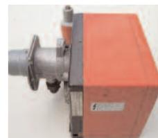
**Anche il bruciatore della sala-teatro** ha avuto più che una manutenzione: oltre ad essere pulite le batterie e il ventilatore, è stata sostituita la valvola di intercettazione del combustibile e rimesso in funzione il termoconvettore che garantirà più caldo in sala.
